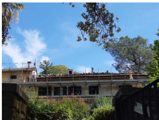
Der lægges nyt undertag på den vestlige tagflade
